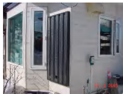
ソーラーウォールパネル取り付け
